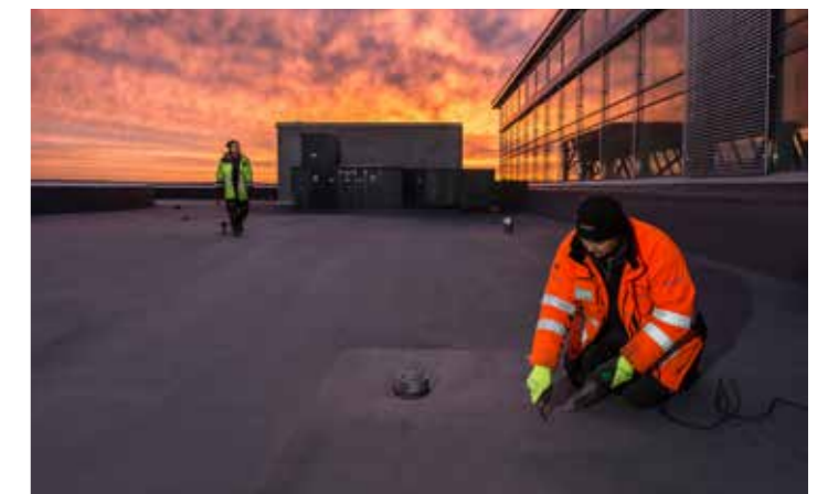
Protans takbelegg og membraner sveises utelukkende med varmluft og er en trygg metode ved tekking av tak.
