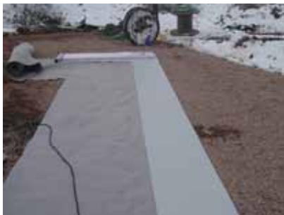
Filt og Protan RadonSafe
