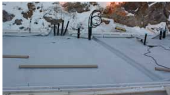
Utlegging og sveising av Protan RadonSafe på flaten
