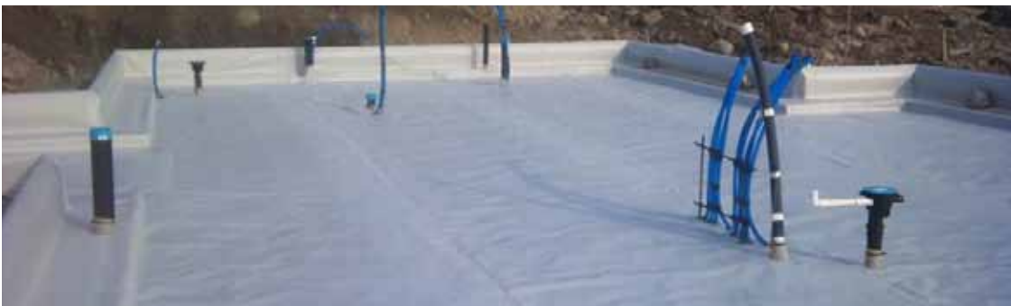
Ferdig lagt Protan Radonsafe – Klart for Isolasjon og betongstøp
